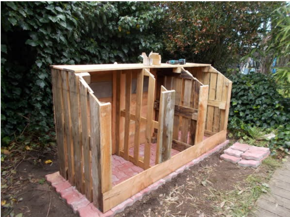
Composteur en bois de palettes et Douglas de seconde main.
